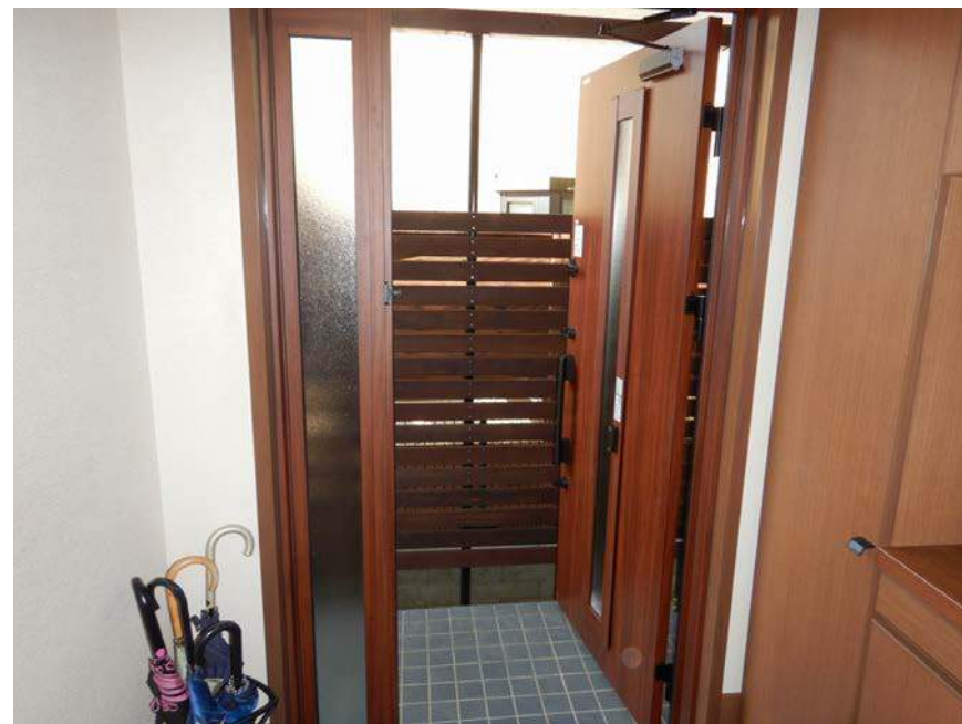
ドア交換設置 (YKKドアリモ) ※枠を残したままでドアを取替
