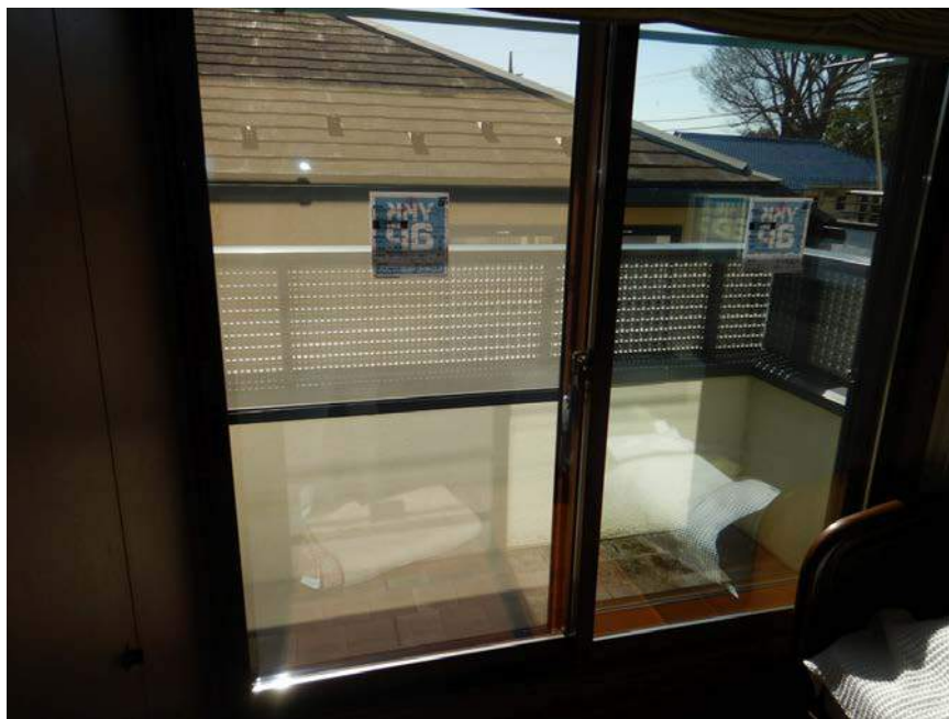
内窓設置 (YKKプラマードU) ※樹脂サッシ (ペアガラス)
